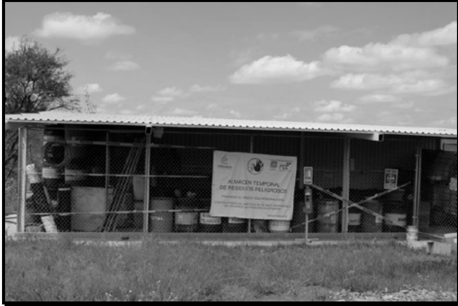
IMAGEN 45. ALMACÉN TEMPORAL DE RESIDUOS PELIGROSOS, UBICADO EN EL ÁREA DEL PROYECTO
