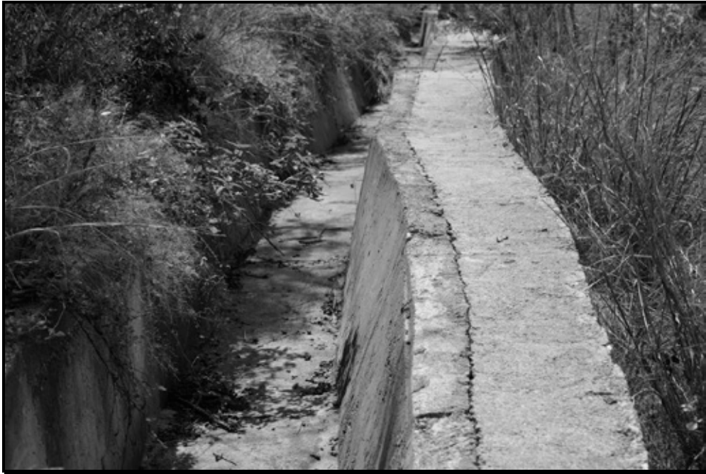
IMAGEN 12. FRACCIÓN DE LA CANALETA DE DESVÍO DE AGUA PLUVIAL UBICADA EN LA SECCIÓN SUPERIOR DE LA OBRA DE CONSTRUCCIÓN, GARANTIZANDO EL CONTROL, CONDUCCIÓN Y ALEJAMIENTO DE LAS AGUAS PLUVIALES
