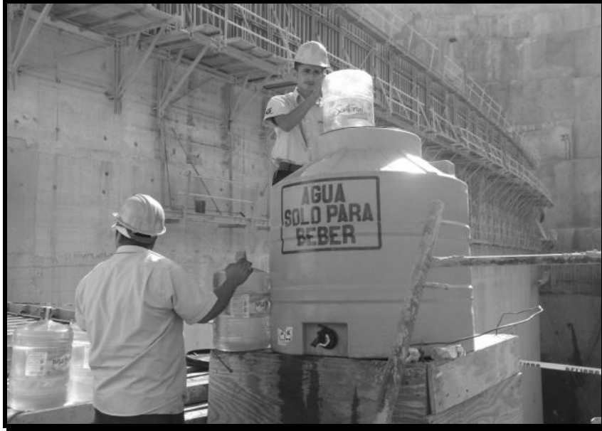
IMAGEN 20. DISTRIBUCIÓN DE AGUA POTABLE A PERSONAL OBRERO
