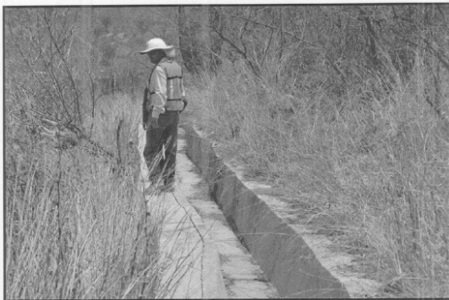
IMÁGEN 31. VERIFICACIÓN DE INFRAESTRUCTURA HIDRÁULICA PARA EL MANEJO, CONTROL Y ALEJAMIENTO DE LOS ESCURRIMIENTOS PLUVIALES, EN EL PERIMETRO DE LAS ÁREAS SUJETAS AL CAMBIO DE USO DEL SUELO EN TERRENOS FORESTALES
