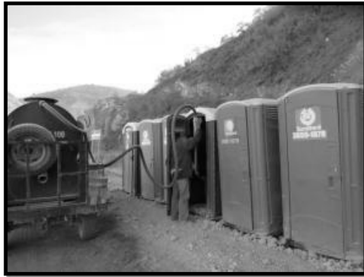
Imagen 22. Servicio de sanitarios portátiles en obra.
