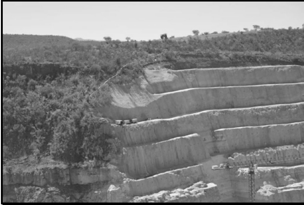
IMAGEN 51. EN EL PERÍMETRO SUPERIOR CORRESPONDIENTE A LA CORONA DE CORTINA SE UBICA LA OBRA DE INFRAESTRUCTURA HIDRÁULICA CON CAPACIDAD SUFICIENTE PARA EL MANEJO, CONTROL Y ALEJAMIENTO DE LOS ESCURRIMIENTOS PLUVIALES
