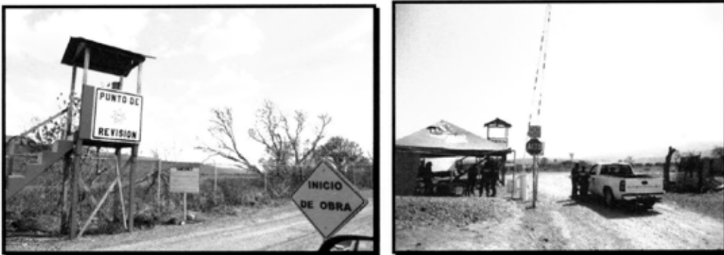
Imágenes 24 y 25. Aspectos de la vigilancia y control de ingreso al proyecto, por personal de la Policía Federal Preventiva, con lo cual se garantiza la omisión de actos indeseables de carecería furtiva en el área.
