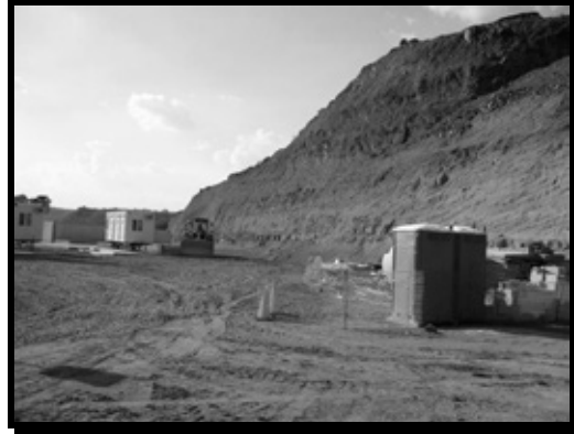
Imagen 29. Servicio de sanitarios portátiles en obra.
