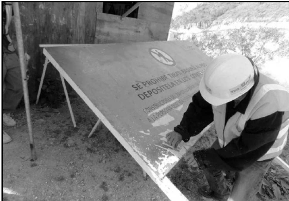
IMAGEN 18.- ACCIONES DE MANTENIMIENTO A CARTELES INFORMATIVOS/PROHIBITIVOS QUE SON DISTRIBUIDOS EN ÁREAS ESTRATEGICAS DENTRO DE LA ZONA DE PROYECTO DE CONSTRUCCIÓN DE LA CORTINA
