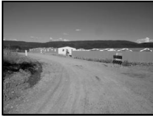
Imagen 24. Instalación de infraestructura temporal.
