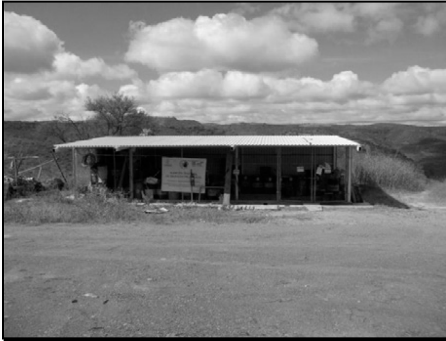
IMAGEN 47. VISTA GENERAL DEL ALMACÉN TEMPORAL DE RESIDUOS PELIGROSOS, UBICADO EN EL ÁREA DEL PROYECTO, EN LA IMAGEN SE IDENTIFICA LA ACCIÓN DE RECOLECCIÓN DE LOS RESIDUOS PELIGROSOS POR LA EMPRESA AUTORIZADA POR LA SEMARNAT
