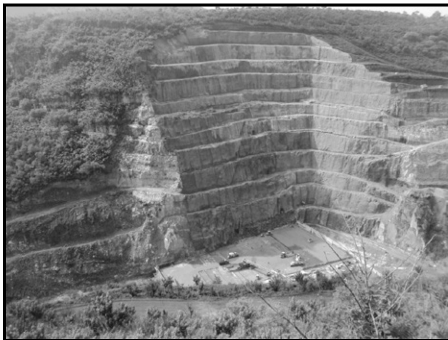
IMAGEN 2. EN EL ÁREA AUTORIZADA PARA EL CUSTF, SE CONTINÚA LA CONSTRUCCIÓN DE LA CORTINA DE LA PRESA “EL ZAPOTILLO”
