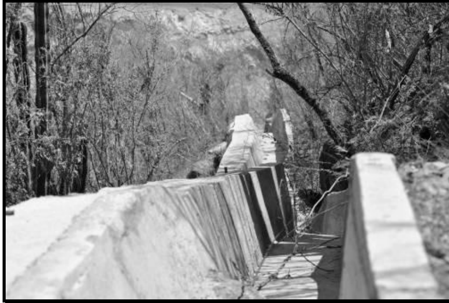
IMAGEN 35. CONDICION ACTUAL DE LA OBRA DE INFRAESTRUCTURA HIDRÁULICA PARA EL MANEJO, CONTROL Y ALEJAMIENTO DE LAS AGUAS PLUVIALES EN LA PORCIÓN PERIMETRAL DEL EMPOTRAMIENTO DE LA PRESA EL ZAPOTILLO
