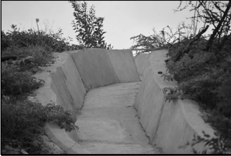
IMAGEN 44.- EN LAS SECCIONES DE LOS POLÍGONOS AUTORIZADOS PARA EL CUSTF, SE HAN ESTABLECIDO OBRAS PARA EL MANEJO, CONTROL Y ALEJAMIENTO DE LAS AGUAS PLUVIALES
