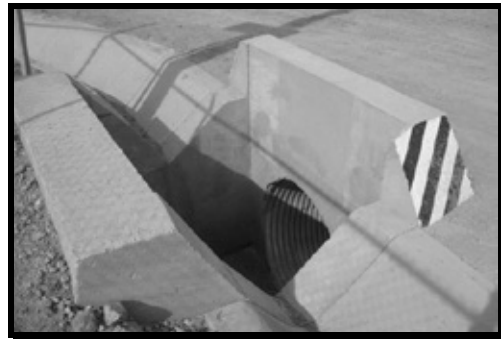
Imágenes 27 y 28. Obras de infraestructura hidráulica para el manejo, control y alejamiento de las aguas pluviales en los caminos internos del proyecto
