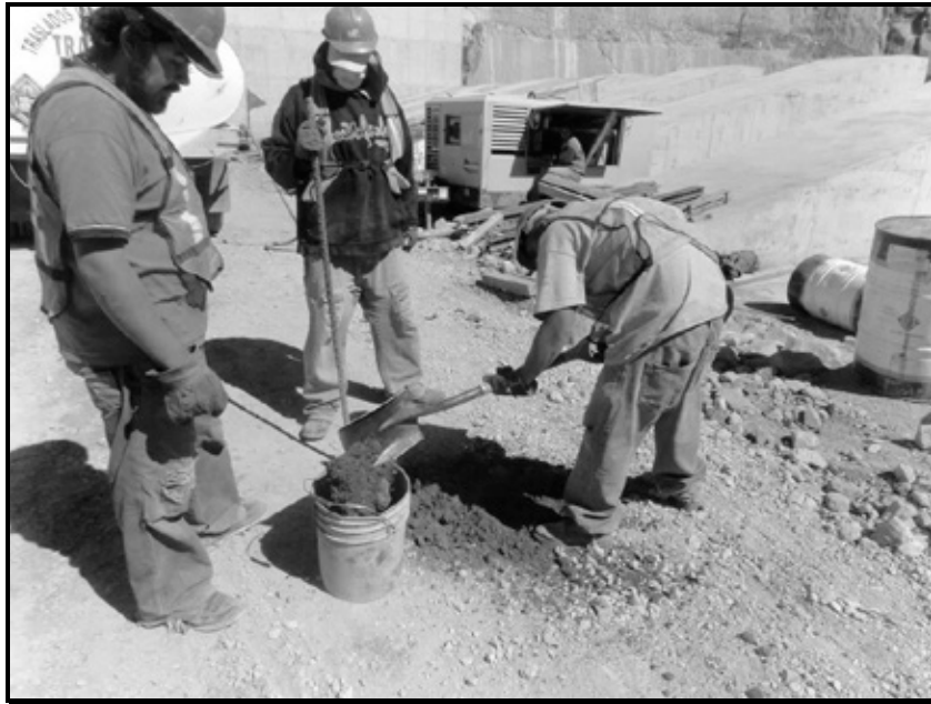
IMAGEN 46. ATENCIÓN OPORTUNA A DERRAMES ACCIDENTALES QUE SE PRESENTAN DURANTE LAS ACTIVIDADES DE CONSTRUCCIÓN DE LA CORTINA
