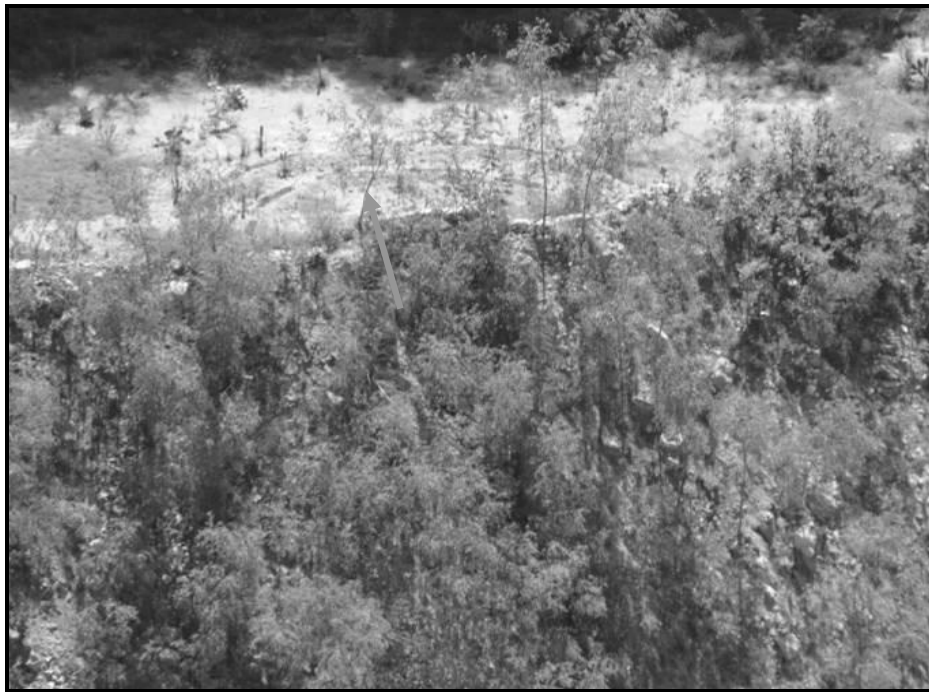
IMAGEN 7. VISTA PANORAMICA DEL ÁREA DONDE SE HAN ESTABLECIDO LAS OBRAS DE CONSERVACIÓN DE SUELO Y AGUA EN EL ÁREA DE FORESTACIÓN "EL ZULA", CONSISTENTES EN ZANJAS TRINCHERA Y GEOCOSTALES
