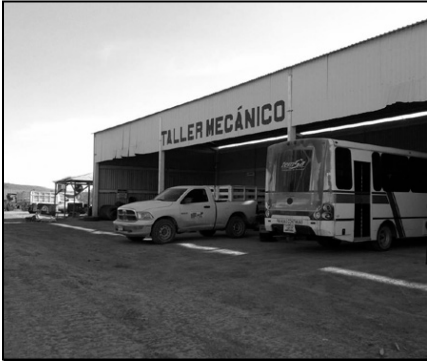
IMAGEN 49. AREA PARA MANTENIMIENTO DE MAQUINARIA Y/O EQUIPOS UTILIZADOS EN EL PROYECTO
