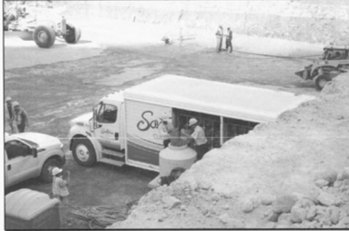
Imagen 39. Distribución de agua potable en obra.
