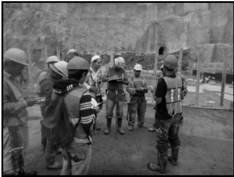
IMAGEN 34. EN LAS ÁREAS DE TRABAJO SE REALIZAN ACCIONES DE CAPACITACIÓN AMBIENTAL AL PERSONAL TRABAJADOR DE LA OBRA CONSTRUCTIVA
