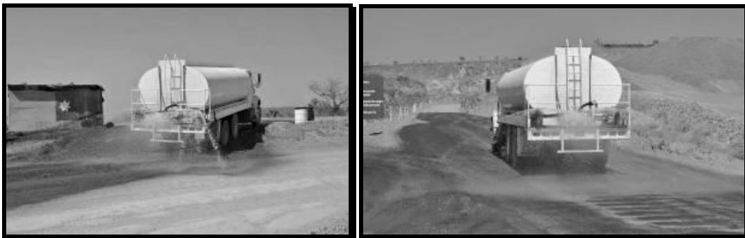
IMÁGENES 43 Y 44. SE MANTIENEN LOS RIEGOS DE CAMINOS INTERNOS COMO MEDIDA PREVENTIVA Y DE MITIGACIÓN DE IMPACTOS PARA LA EMISIÓN DE POLVOS FUGITIVOS
