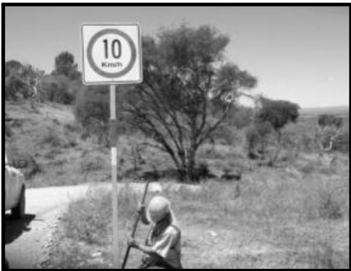
Imagen 15. Señalamientos de velocidad colocados en los caminos de acceso a la obra.
