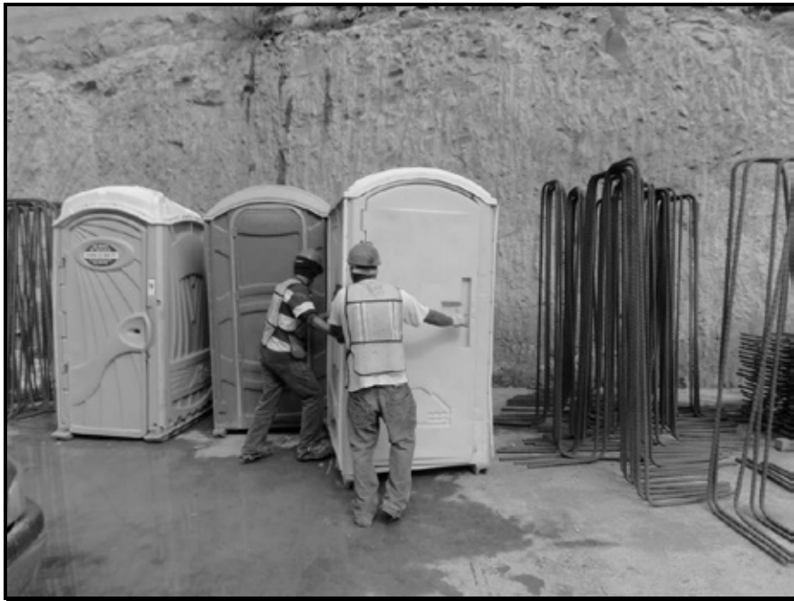
IMAGEN 37.- LOS SANITARIOS PORTÁTILES SON DISTRIBUIDOS EN LOS FRENTE DE TRABAJO PARA EL SERVICIO DEL PERSONAL OBRERO
