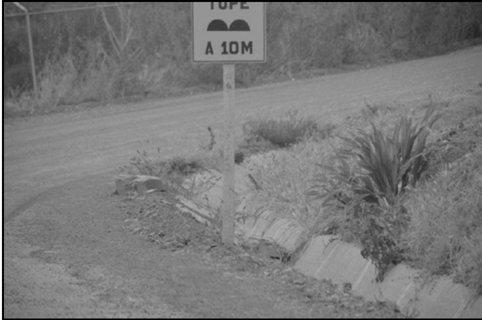
IMÁGEN 24. SE HAN ESTABLECIDO EN LAS ÁREAS DEL PROYECTO INFRAESTRUCTURAS DE INGENIERÍA HIDRÁULICA PARA EL MANEJO CONTROL Y ALEJAMIENTO DE LOS ESCURRIMIENTOS PLUVIALES, HACIA LOS ESCURRIMIENTOS PLUVIALES ORIGINALES
