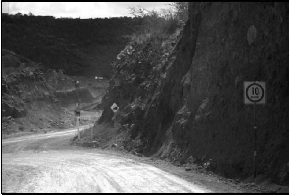
IMAGEN 14. SEÑALIZACIÓN DE LÍMITE DE VELOCIDAD Y PRESENCIA DE FAUNA EN CAMINO DE ACCESO AL PROYECTO DE CONSTRUCCIÓN DE CORTINA
