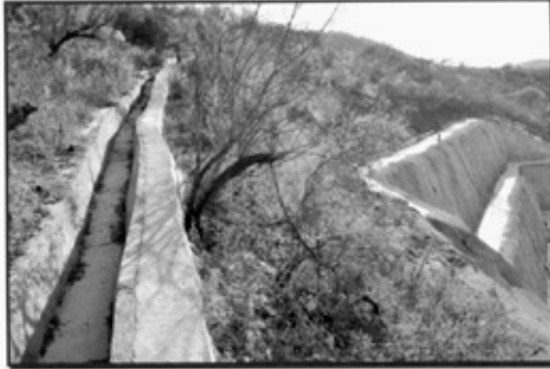
Imagen 42. Aspecto de los canales de desvío, en áreas específicas de la cortina de la presa, con el objetivo de manejar, controlar y alejar los escurrimientos pluviales
