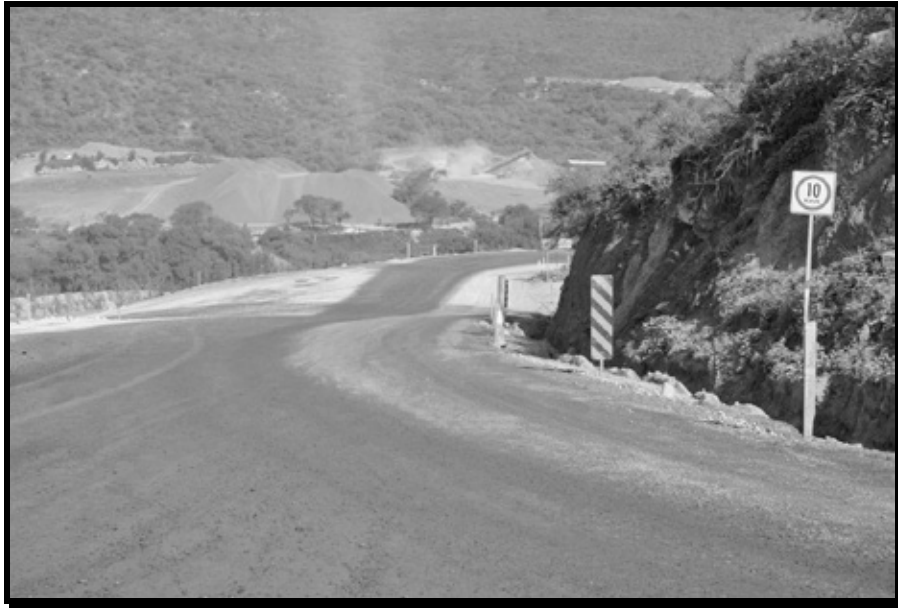
IMAGEN 22. EN LOS CAMINOS INTERNOS DEL PROYECTO SE MANTIENEN LOS RIEGOS CONTÍNUOS Y LAS SEÑALIZACIONES DE VELOCIDAD LIMITADA EN LOS MISMOS
