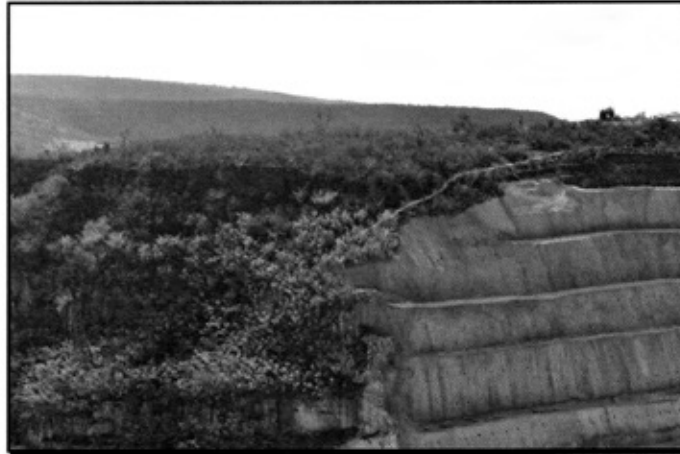
Imagen 1. Vista general de la sección territorial donde se empotrará la cortina de la Presa El Zapotillo, respetándose las secciones territoriales perimetrales a los polígonos autorizados para el Cambio de Uso de Suelo en Terrenos Forestales (CUSTF)
