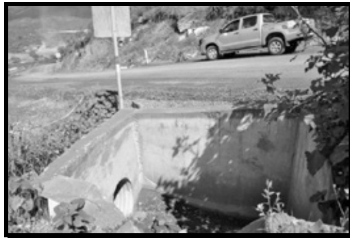
Imagen 35. Obra de infraestructura hidráulica para el manejo, control y alejamiento de las aguas pluviales en los caminos internos del proyecto
