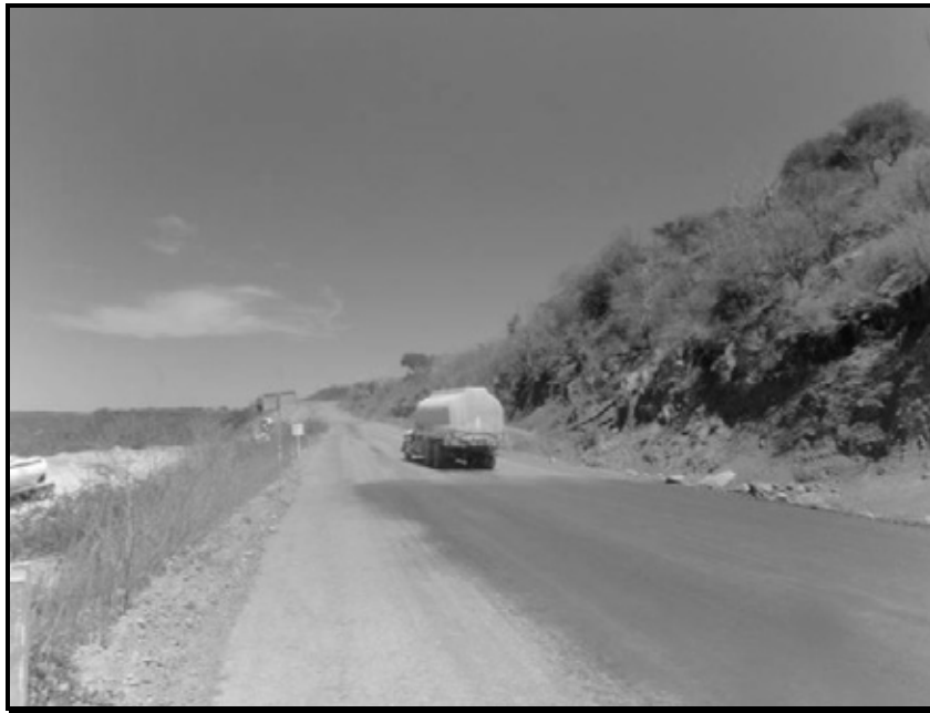
IMAGEN 39. RIEGO DE LOS CAMINOS INTERNOS DEL PROYECTO PARA LA MINIMIZACIÓN DE POLVOS FUGITIVOS
