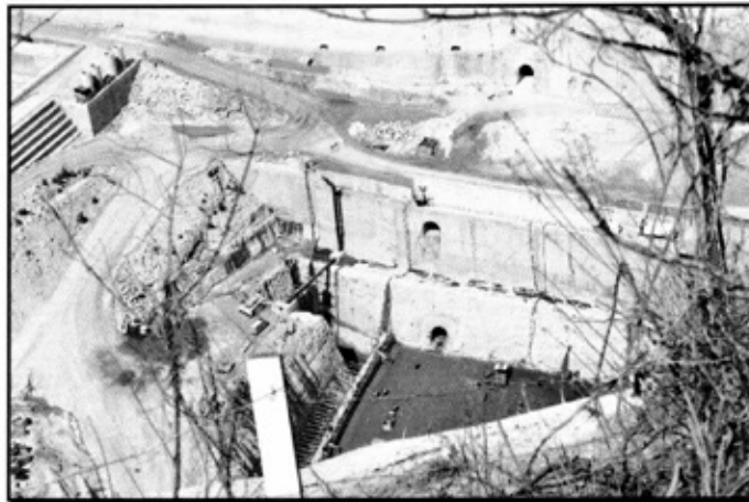
Imagen 2. En las áreas autorizadas para el CUSTF, es donde se ejecutan las obras civiles de cimentación de la Cortina de la Presa "El Zapotillo"
