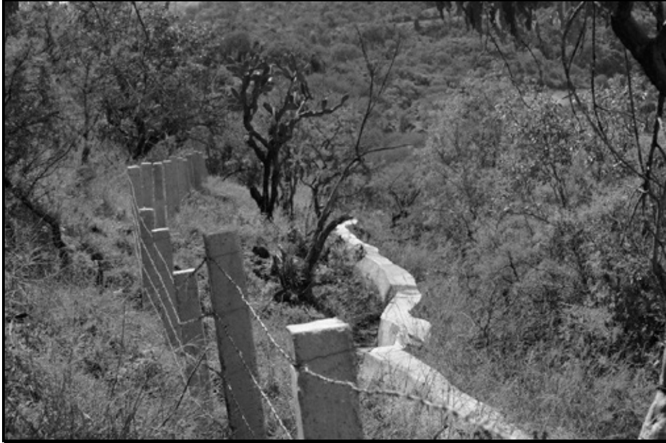
IMAGEN 6. ASPECTO GENERAL DEL CANAL DE DESVÍO Y CERCADO CON ALAMBRADO DE PÚAS QUE DELIMITA LAS ÁREAS DONDE SE EJECUTA LA CONSTRUCCIÓN DE LA CORTINA DE LA PRESA EL ZAPOTILLO, UBICADO AGUAS ARRIBA DEL TALUD SOBRE EL CUAL SE CONSTRUYE LA CORTINA DE LA PRESA
