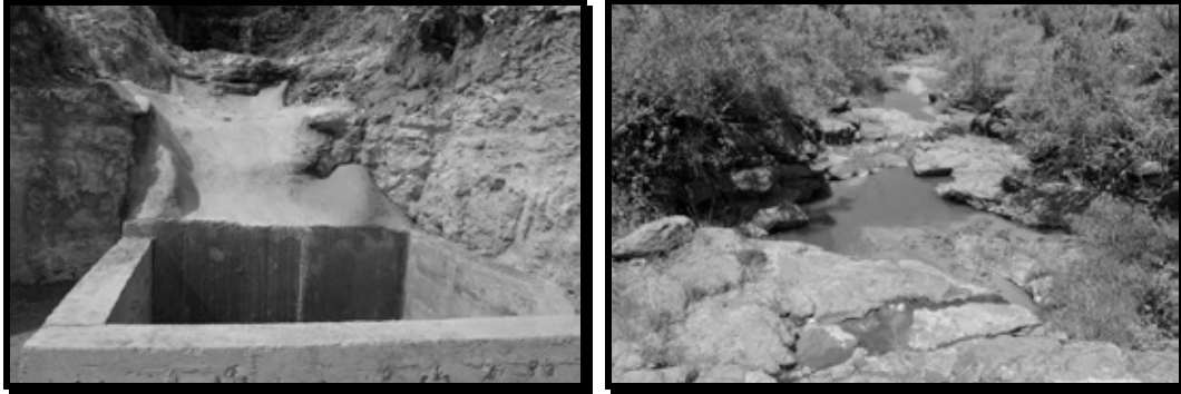
IMÁGENES 46 Y 47. SE HAN ESTABLECIDO EN LAS ÁREAS DEL PROYECTO INFRAESTRUCTURAS DE INGENIERÍA HIDRÁULICA PARA EL MANEJO CONTROL Y ALEJAMIENTO DE LOS ESCURRIMIENTOS PLUVIALES, HACIA LOS ESCURRIMIENTOS PLUVIALES ORIGINALES
