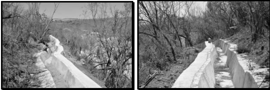
Imágenes 46 y 47. Vistas generales del canal de desvío en el perímetro de la cortina de la Presa (Área de concreto lanzado), con lo cual se ha garantizado el manejo control y alejamiento de los escurrimientos pluviales
