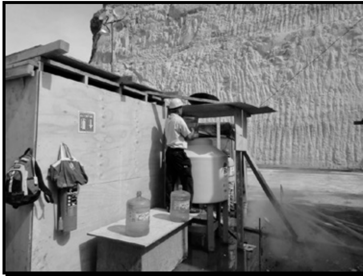
Imagen 30. Distribución de agua potable en obra.
