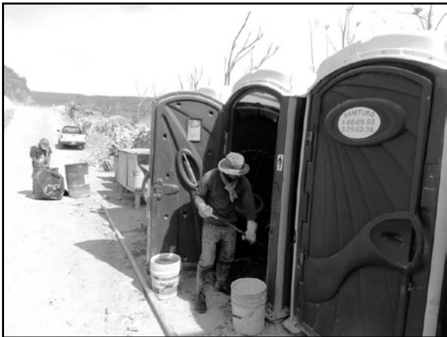
IMAGEN 38. ACCIÓN DE MANTENIMIENTO Y LIMPIEZA A SANITARIOS PORTÁTILES QUE SE TIENEN A DISPOSICIÓN DEL PERSONAL EN LAS ÁREAS DE OBRA
