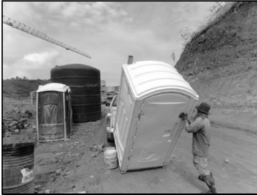
IMAGEN 30.- DISTRIBUCIÓN Y REUBICACIÓN DE SANITARIOS PORTÁTILES HACIA LOS FRENTES DE TRABAJO QUE ASÍ LO REQUIEREN
