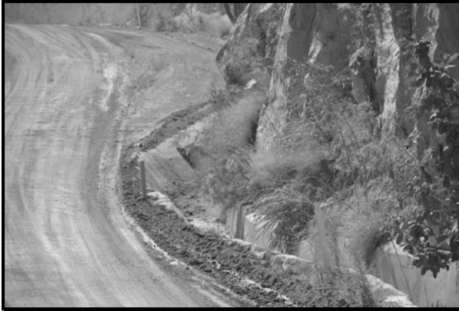
IMAGEN 36. ASPECTO DE LA SECCIÓN DE CUNETA DE CONCRETO, PARA EL MANEJO, CONTROL Y ALEJAMIENTO DE AGUAS PLUVIALES
