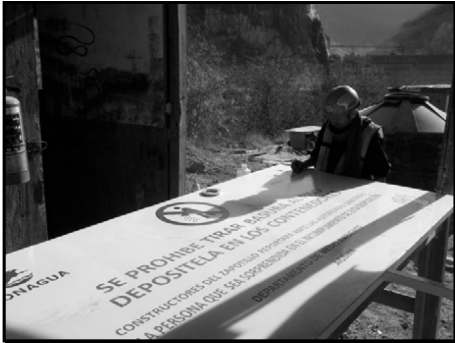
IMAGEN 10. MANTENIMIENTO A PANTALLAS INFORMATIVAS/PROHIBITIVAS INSTALADAS AL INTERIOR DEL PROYECTO
