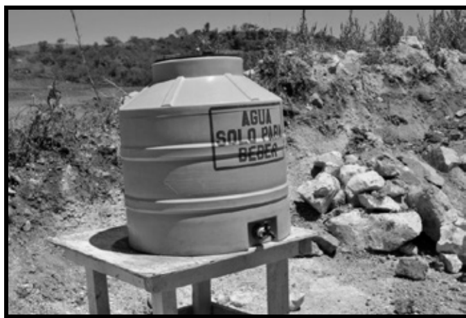
Imagen 37. Distribución de agua potable en obra.
