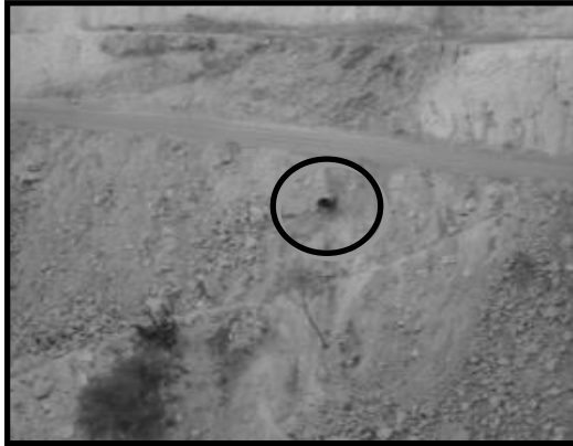
Imagen 35. Se observa en la fotografía un dren en camino VCD-8 para guiar los escurrimientos hacia el cauce del Río Verde.
