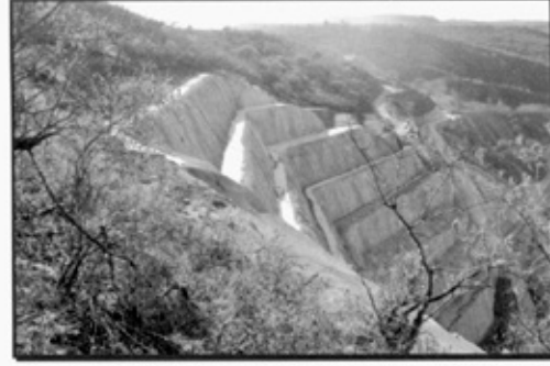
Imagen 43. La preparación de la Infraestructura de empotramiento de la Cortina de la Presa, con concreto lanzado, ha resultado apoyada por las obras de ingeniería hidráulica, correspondientes a cunetas y canales de desvío, evitando su impacto directo sobre suelos desnudos
