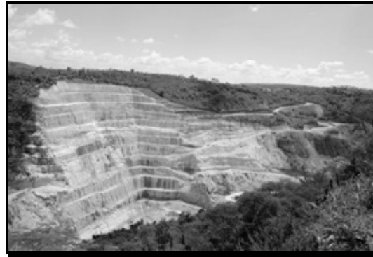
Imagen 2. En las áreas autorizadas para el CUSTF, es estrictamente donde se realizan las acciones preparación de sitio y modelación topográfica para el empotramiento y cimentación de la Cortina de la Presa "El Zapotillo".
