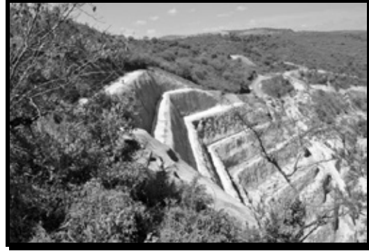
Imagen 43. Preparación de la Infraestructura de empotramiento de la Cortina de la Presa, misma que ha resultado apoyada por las obras de ingeniería hidráulica, correspondientes a cunetas y canales de desvío, evitando su impacto directo
