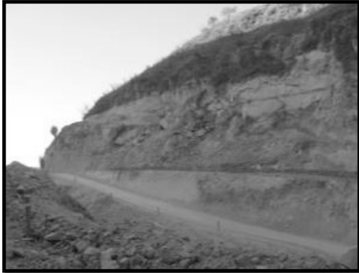
Imagen 34. Se construyeron cunetas en los caminos para conducir los escurrimientos al Río Verde. Camino VCI-9
