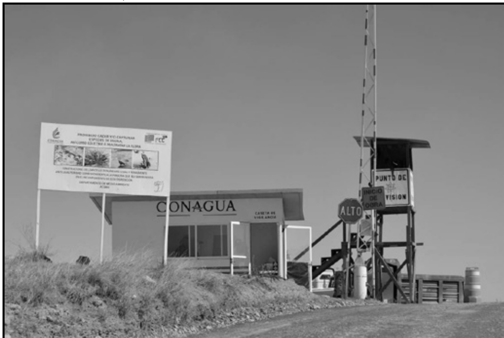
IMAGEN 26. SE MANTIENEN EN LOS INGRESOS AL SITIO DE PROYECTO CONSTRUCTIVO LOS PUESTOS DE VERIFICACIÓN, ATENDIDO POR PERSONAL DE PROTECCIÓN FEDERAL, MISMOS QUE INHIBEN ACCIONES ILÍCITAS AMBIENTALES EN EL ÁREA DE PROYECTO
