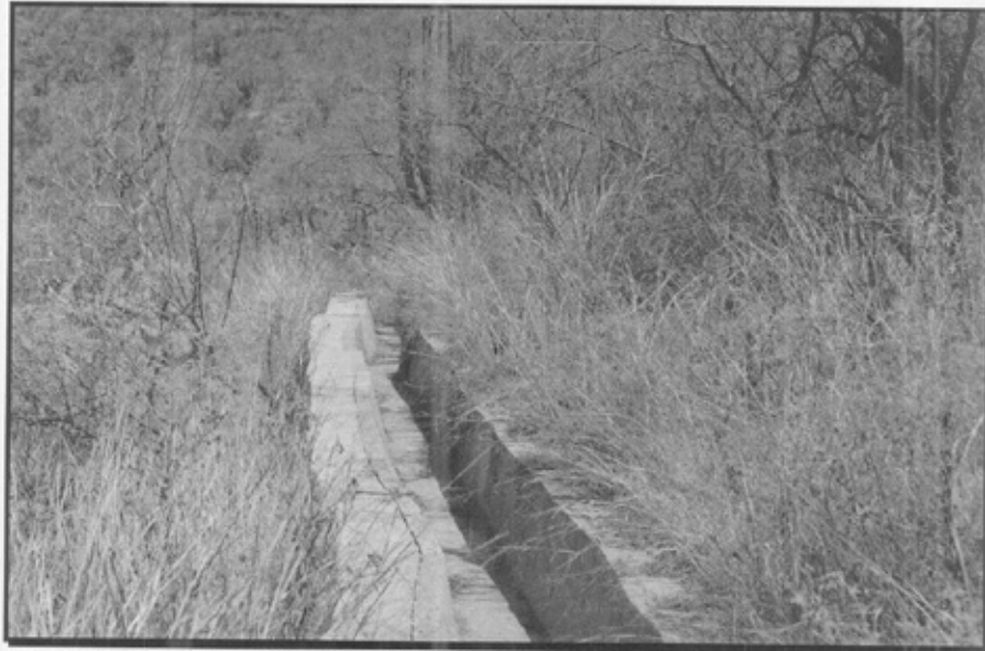
IMAGEN 22. SECCIÓN DE CANAL DE ENCAUSAMIENTO DE LAS AGUAS PLUVIALES, UBICADO EN EL PERÍMETRO DEL ÁREA DE PROYECTO
