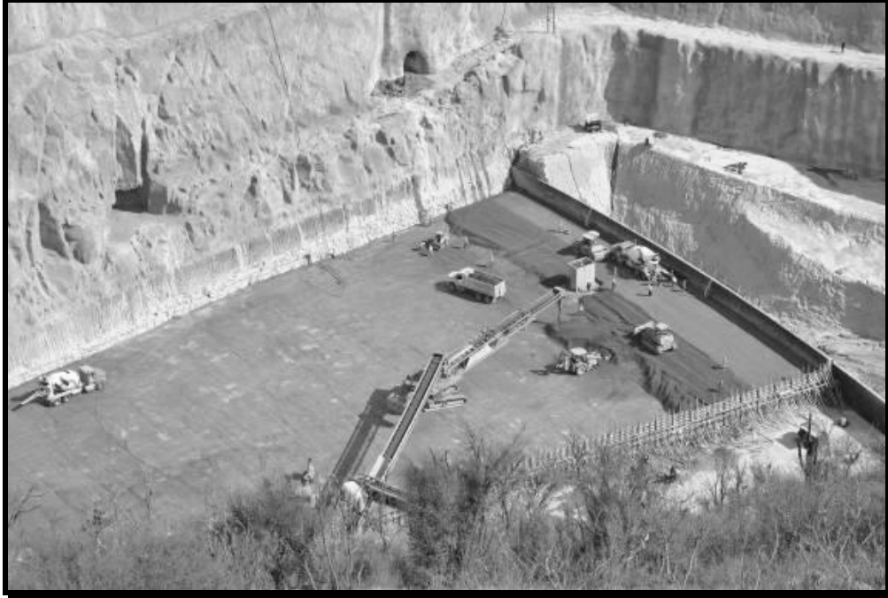
IMAGEN 2. EN EL ÁREA AUTORIZADA PARA EL CUSTF, SE REALIZA LA INCORPORACIÓN DE CONCRETO COMPACTADO CON RODILLO (CCR), MISMO QUE CONFORMARÁ EN SU OPORTUNIDAD LA CORTINA DE LA PRESA “EL ZAPOTILLO”
