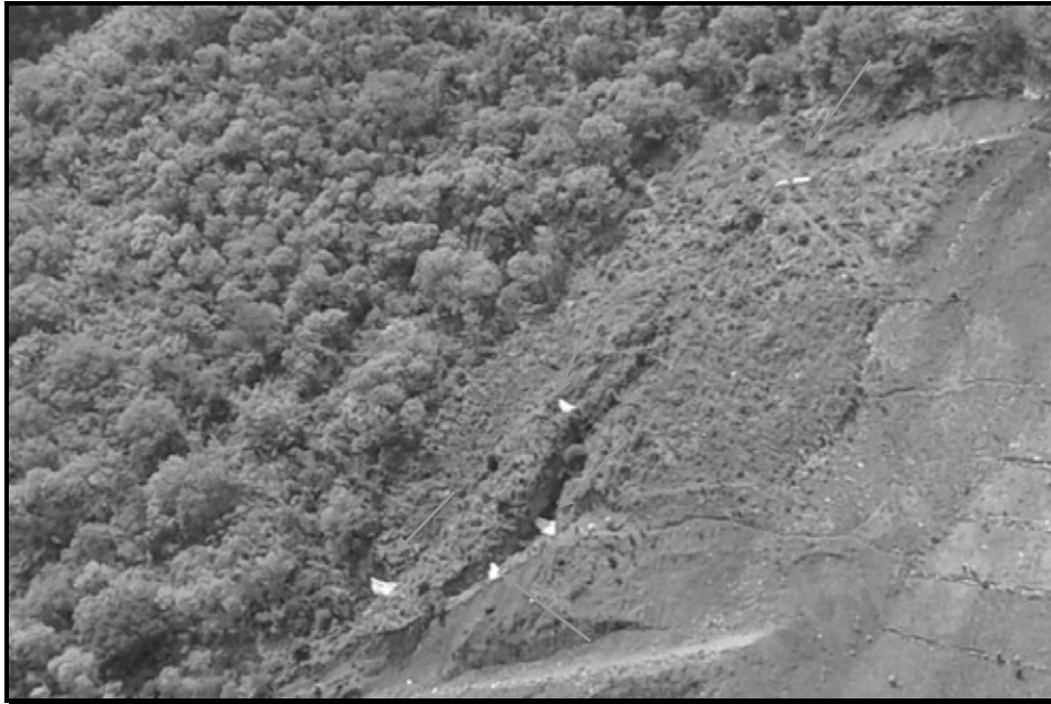
IMAGEN 6. VISTA ACTUAL DE SECCIÓN DE RESTAURACIÓN EN LA QUE SE HAN CONSTRUIDO OBRAS PARA LA CONSERVACIÓN DE SUELO Y AGUA, A TRAVÉS DE GEOCOSTALES
