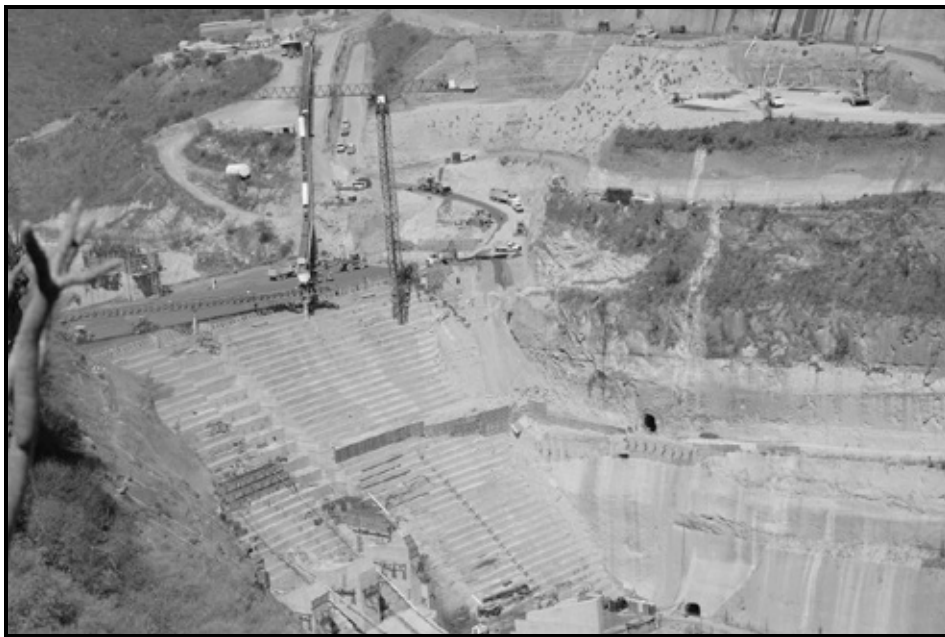
IMAGEN 14.- VISTA GENERAL DEL AVANCE CONSTRUCTIVO DE LA CORTINA DE LA PRESA “EL ZAPOTILLO”, ATENDIENDO SECCIONES AUTORIZADAS PARA EL CAMBIO DE USO DEL SUELO EN TERRENOS FORESTALES
