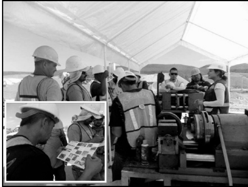
IMAGEN 17. SE DÁ CONTINUIDAD A LAS ACCIONES DE CAPACITACIÓN AMBIENTAL AL PERSONAL TRABAJADOR DE LA OBRA CONSTRUCTIVA EN LAS ÁREAS DE TRABAJO
