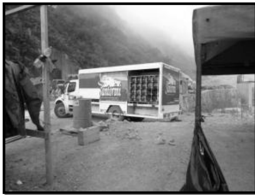
Imagen 23. Distribución de agua potable en obra.
