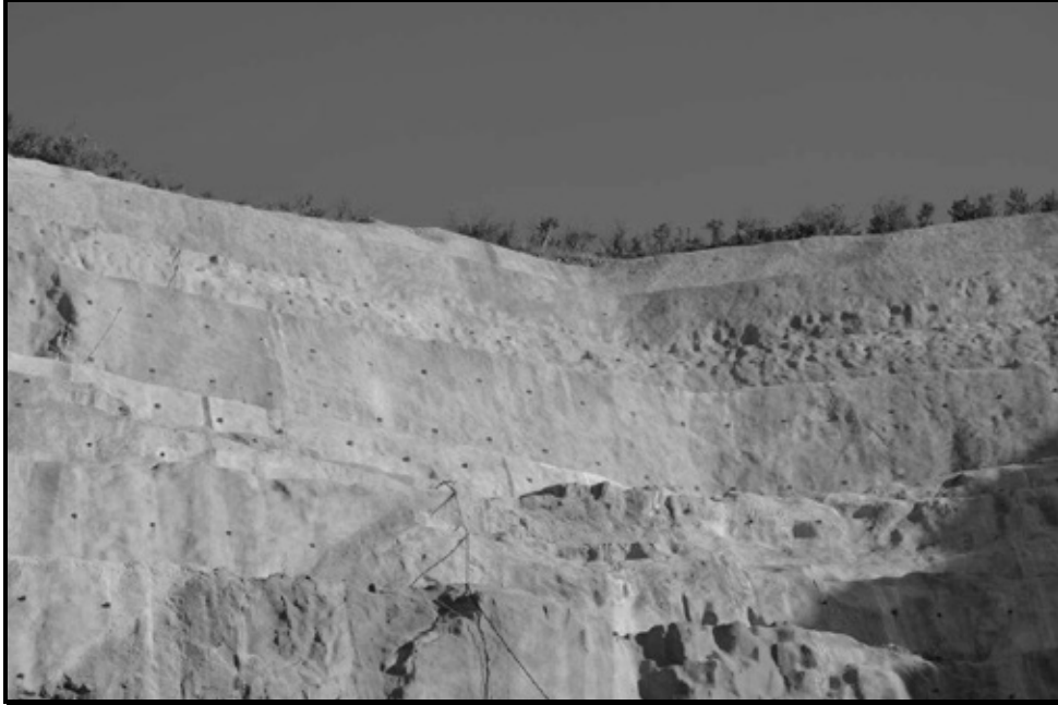
IMAGEN 7. ASPECTO GENERAL DEL TALUD SOBRE EL CUAL SE DESPLANTARÁ EL EMPOTRAMIENTO O CIMENTACIÓN DE LA CORTINA DE LA PRESA
