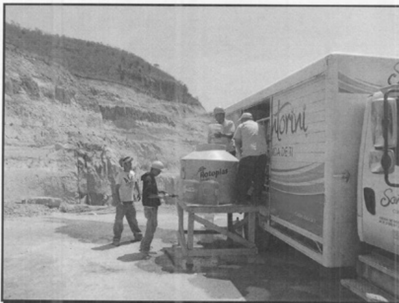
IMAGEN 25. DISTRIBUCIÓN DE AGUA POTABLE EN LAS ÁREAS DE TRABAJO
