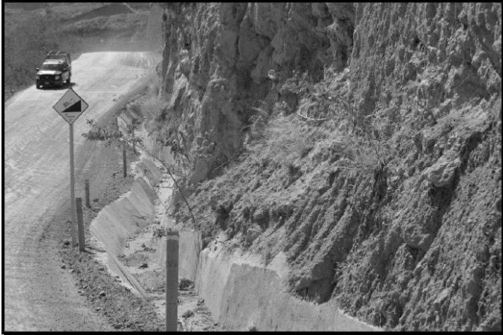
IMÁGEN 26. INFRAESTRUCTURA HIDRÁULICA PARA EL MANEJO, CONTROL Y ALEJAMIENTO DE LOS ESCURRIMIENTOS PLUVIALES
