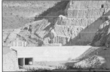
Imagen 2. Solamente en las áreas autorizadas para el CUSTF, son ejecutadas las acciones de la etapa de preparación de sitio y construcción de la Cortina de la Presa "El Zapotillo".
