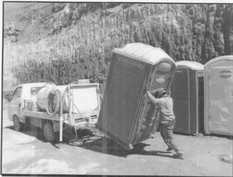
IMAGEN 23.- SE REALIZAN REDISTRIBUCIONES DE SANITARIOS PORTÁTILES EN LAS ÁREAS DE TRABAJO QUE LO REQUIEREN
