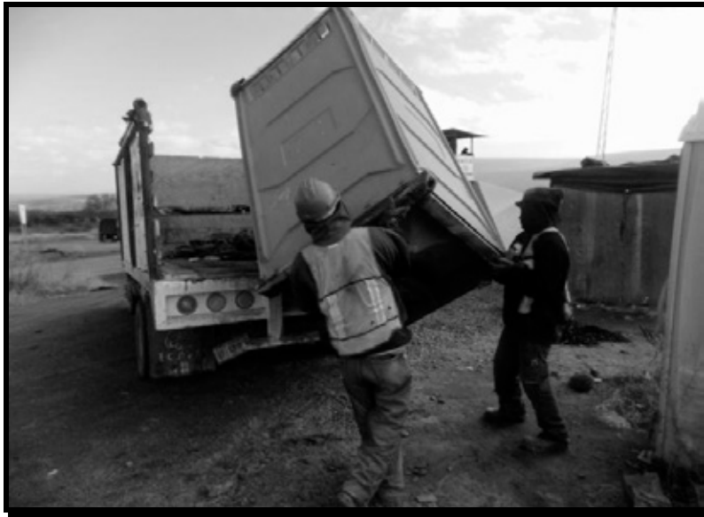
IMAGEN 19. MOVIMIENTO O REDISTRIBUCIÓN DE SANITARIOS PORTÁTILES HACIA LOS FRENTE DE TRABAJO
