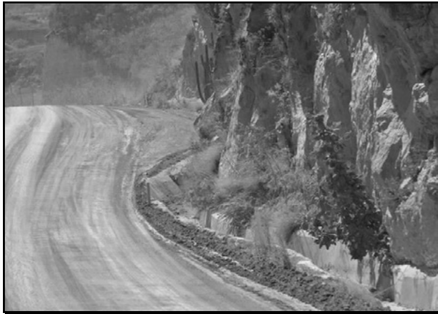
IMAGEN 29. CUNETA DE CONCRETO PARA MANEJO DE AGUA PLUVIAL EN EL CAMINO VCD-8
