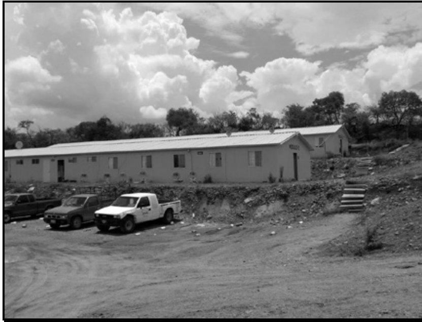
IMAGEN 35. VISTA PARCIAL DE ZONA DE CAMPAMENTOS PARA TRABAJADORES DEL PROYECTO
