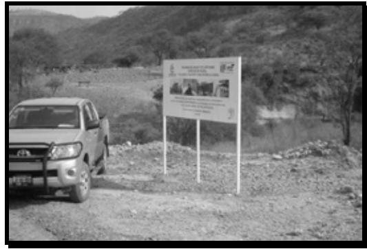
Imagen 23. Pantallas de información ambiental distribuidas en diferentes zonas de la obra.
