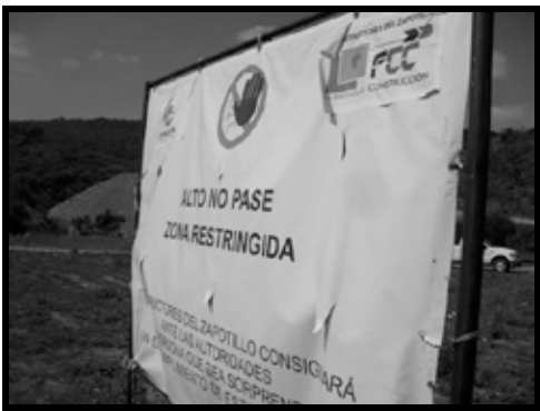
Imagen 24. Pantalla informativa de restricción al paso de transeúntes en uno de los accesos al sitio de proyecto.
