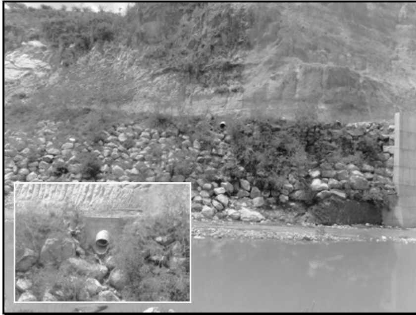
IMAGEN 8. VISTA PARCIAL DE LA CANALETA PARA EL MANEJO CONTROL Y ALEJAMIENTO DE AGUAS PLUVIALES, LA CUAL SE UBICA EN LA SECCIÓN SUPERIOR DE LA OBRA DE CONTENCIÓN
