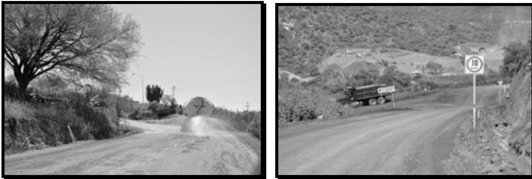
Imagen 40. Riego de caminos como medida preventiva para el control de emisión de polvos fugitivos, así como el control de las velocidades máximas
