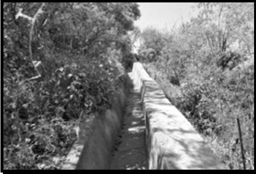
Imagen 42. A la fecha se han operado eficientemente las cunetas y canales de desvío, en áreas específicas de la cortina de la presa, con el objetivo de manejar, controlar y alejar los escurrimientos pluviales
