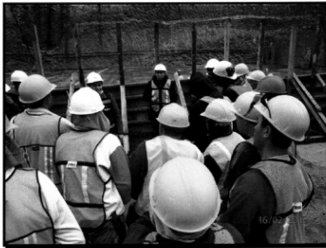
Imagen 33. Capacitación ambiental al personal trabajador de la obra constructiva en el sitio de trabajo
