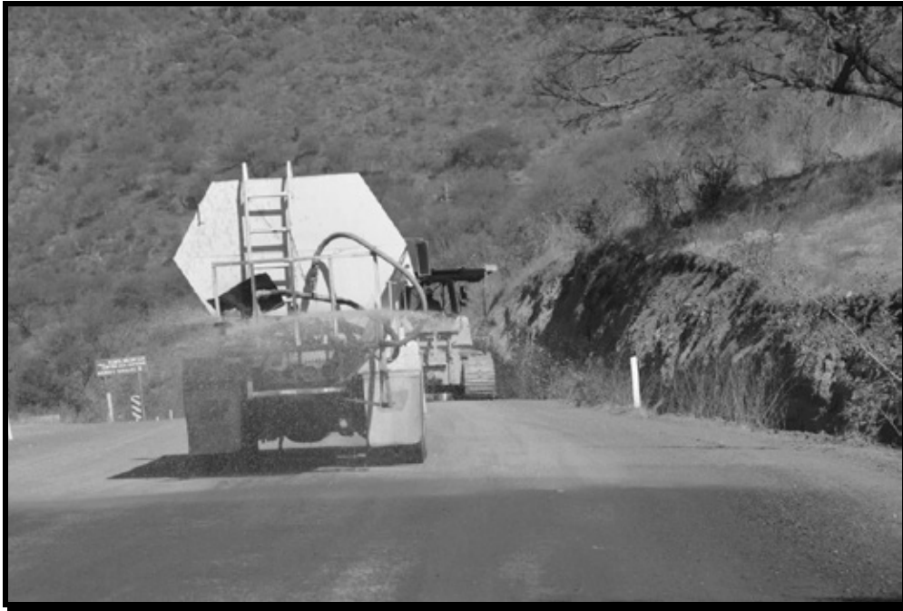
IMAGEN 45. RIEGO DE LOS CAMINOS INTERNOS DEL PROYECTO, MINIMIZANDO LA EMISIÓN DE POLVOS FUGITIVOS, DE IGUAL FORMA A LAS MAQUINARIAS Y EQUIPOS SE LES BRINDAN MANTENIMIENTOS PREVENTIVOS MINIMIZANDO LA EMISIÓN DE GASES
