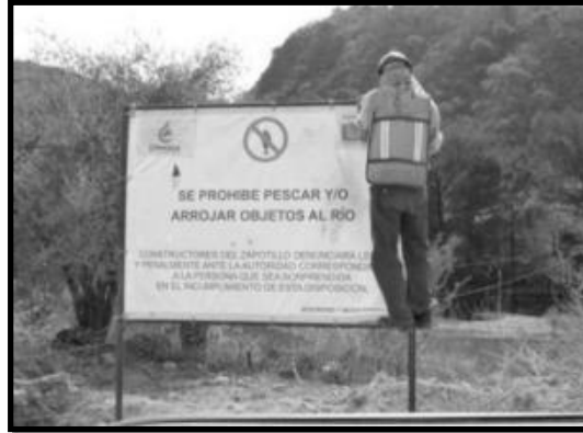
Imagen 18. Colocación de lonas de protección a la flora y fauna.
