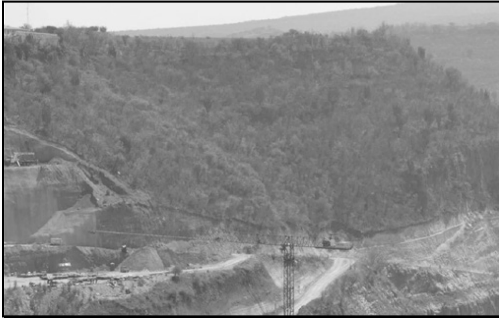
IMAGEN 9.- MANTENIMIENTO DE LAS CONDICIONES ORIGINALES DE VEGETACIÓN EN LAS COLINDANCIAS DEL ÁREA DE CONSTRUCCIÓN DE LA CORTINA
