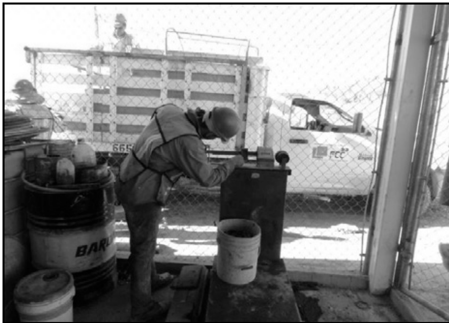
IMAGEN 42. PESADO, REGISTRO E INGRESO DE RESIDUOS PELIGROSOS AL ALMACEN DE RESIDUOS PELIGROSOS DEL PROYECTO
