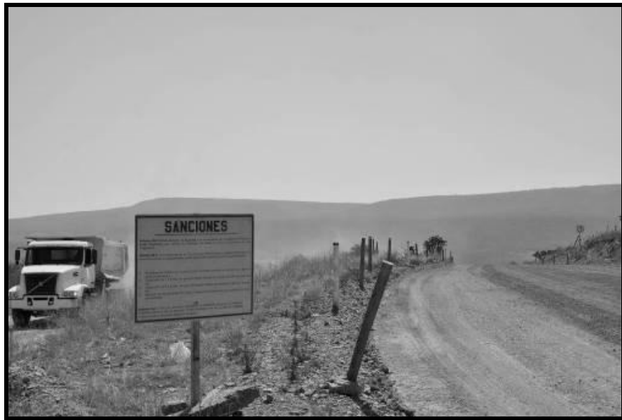
IMAGEN 23. SE MANTIENEN LAS SEÑALIZACIONES DE SANCIONES AL PERSONAL TRABAJADOR EN CASO DE QUE DESATIENDAN LAS INSTRUCCIONES Y CRITERIOS AMBIENTALES QUE GARANTICEN LA PREVENCIÓN DE AFECTACIONES AL ECOSISTEMA FUERA DE LAS ÁREAS DE TRABAJO CONSIDERADAS EN EL CUSTF
