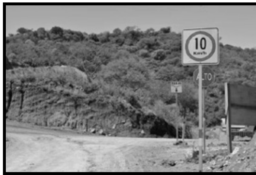
Imagen 24. Señalizaciones de velocidad limitada en los caminos internos del proyecto
