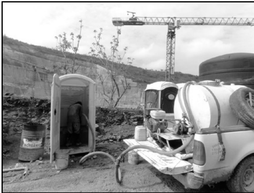
IMAGEN 31. LIMPIEZA RUTINARIA DE SANITARIOS PORTÁTILES DISTRIBUIDOS EN LAS ÁREAS DE TRABAJO
