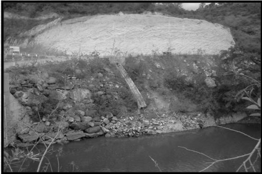
IMAGEN 50.- SE MANTIENEN EN EL PERIMETRO DE LAS SECCIONES INTERVENIDAS ESTABLECIMIENTO DE OBRAS PARA EL MANEJO, CONTROL Y ENCAUSAMIENTO DE LAS AGUAS PLUVIALES
