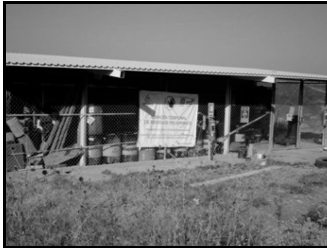
IMAGEN 24. ALMACÉN TEMPORAL DE RESIDUOS PELIGROSOS, UBICADO EN EL ÁREA DEL PROYECTO
