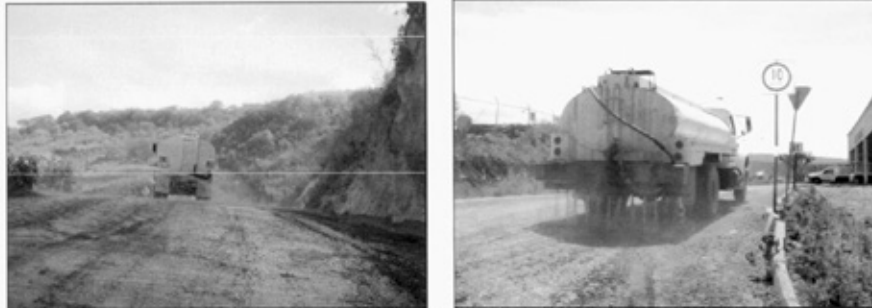
Imagen 42 y 43. Riego de caminos como medida preventiva y de mitigación de impactos para la emisión de polvos fugitivos, así como el control de las velocidades máximas
