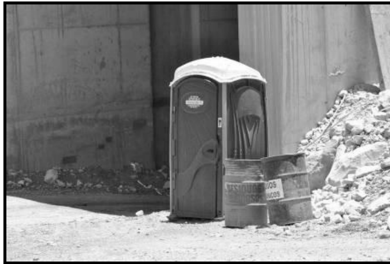
IMAGEN 36. SANITARIOS PORTÁTILES DISPUESTOS EN LAS ÁREAS DE TRABAJO DEL PROYECTO
