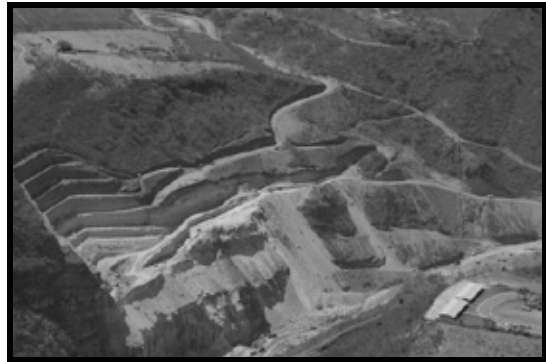
Imagen 2. En las áreas autorizadas para el CUSTF se realiza de forma inmediata al desmonte, la preparación de sitio y modelación topográfica para el empotramiento y cimentación de la cortina de la presa "El Zapotillo".
