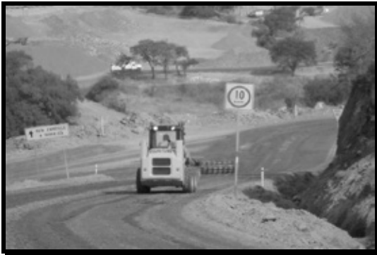
Imagen 22. Señalamientos de velocidad colocados en los caminos internos de la obra.
