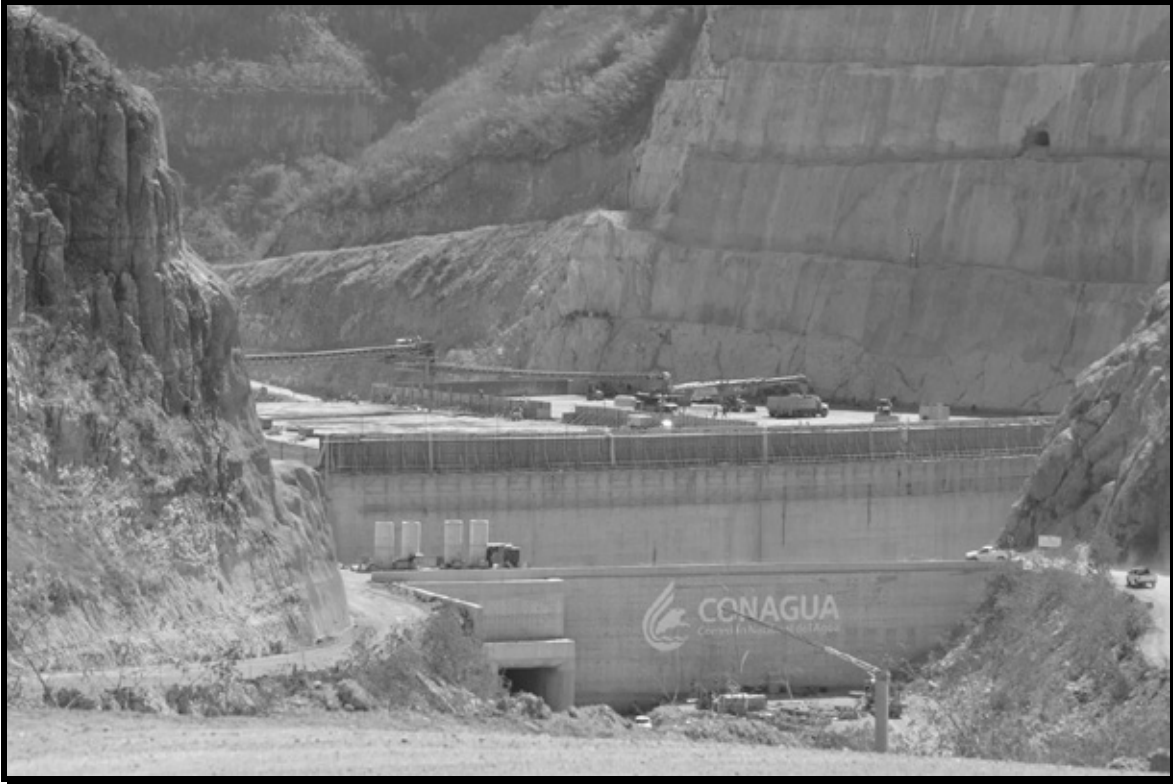
IMAGEN 7. ASPECTO GENERAL DEL AVANCE CONSTRUCTIVO DE LA CORTINA DE LA PRESA “EL ZAPOTILLO”, EN LA CUAL NO SE IDENTIFICAN SECCIONES TERRITORIALES CON SUELOS DESNUDOS O CON PROCESOS HÍDRICO-EROSIVOS
