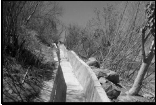
Imagen 34. Se construyeron cunetas en áreas específicas de la cortina de la presa, con el objetivo de manejar, controlar y alejar los escurrimientos pluviales
