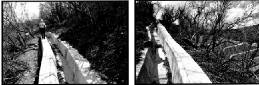
Imágenes 45 y 46. Vistas generales del canal de desvío en el perímetro de la cortina de la Presa (Área de concreto lanzado), con lo cual se ha garantizado el manejo control y alejamiento de los escurrimientos pluviales
