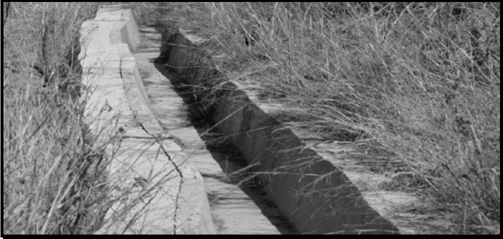
IMAGEN 18. SECCIÓN DE CANAL DE DESVÍO DE AGUAS PLUVIALES, UBICADO EN EL PERÍMETRO DEL ÁREA DE PROYECTO
