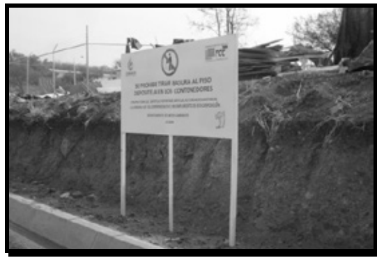
Imagen 25. Pantalla prohibitiva colocada en la zona de trabajo.
