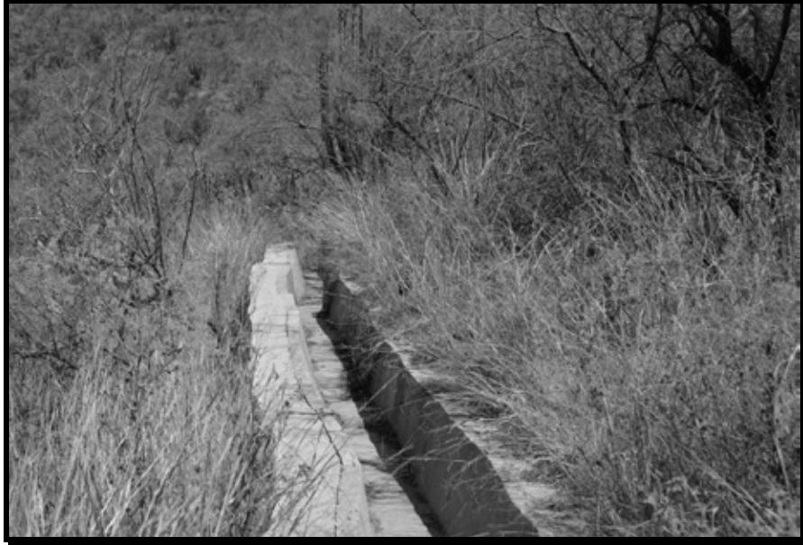
IMAGEN 6. VISTA PARCIAL DEL CANAL DE DESVÍO QUE DELIMITA LA PARTE SUPERIOR DEL EMPOTRAMIENTO DE LA CORTINA DE LA PRESA “EL ZAPOTILLO”, EN LA MARGEN DERECHA DEL RÍO VERDE
