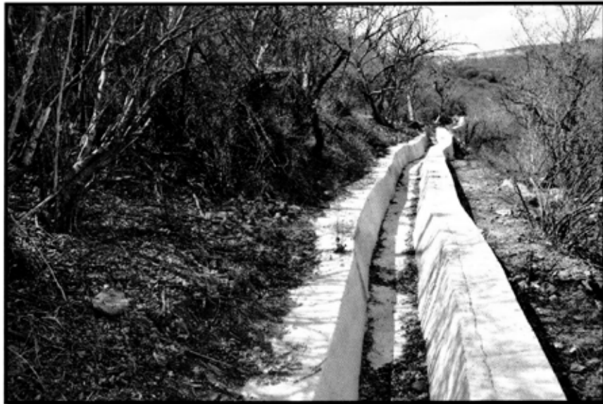
Imagen 34. Obra de infraestructura hidráulica para el manejo, control y alejamiento de las aguas pluviales en la porción perimetral del empotramiento de la Presa El Zapotillo
