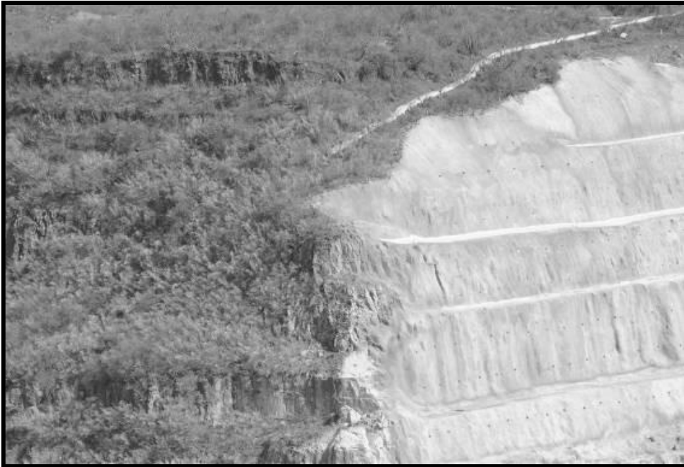
IMAGEN 1. SECCIÓN TERRITORIAL DE LA CORTINA DE LA PRESA EL ZAPOTILLO, DONDE SE UBICA LA INFRAESTRUCTURA DE CANAL QUE PER MITE EL MANEJO CONTROL Y ALEJAMIENTO DE LAS AGUAS PLUVIALES, EN EL LÍMITE DE LOS POLÍGONOS AUTORIZADOS PARA EL CAMBIO DE USO DE SUELO EN TERRENOS FORESTALES (CUSTF)
