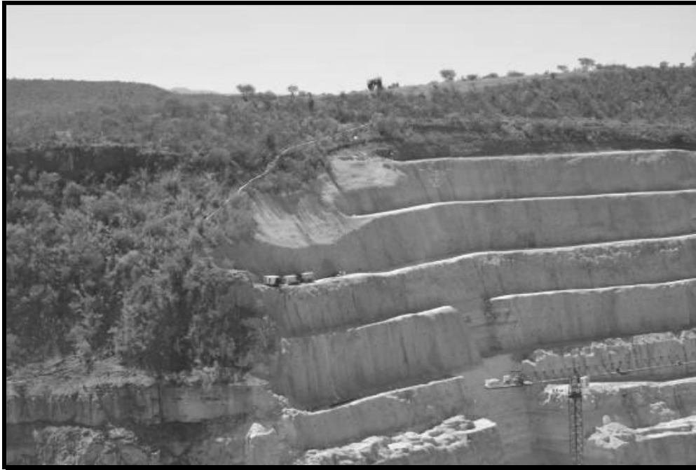
IMAGEN 45. EN EL PERIMETRO SUPERIOR CORRESPONDIENTE A LA CORONA DE CORTINA SE UBICA LA OBRA DE INFRAESTRUCTURA HIDRÁULICA CON CAPACIDAD SUFICIENTE PARA EL MANEJO, CONTROL Y ALEJAMIENTO DE LOS ESCURRIMIENTOS PLUVIALES
