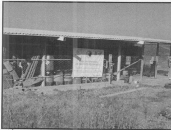
IMAGEN 29. ALMACÉN TEMPORAL DE RESIDUOS PELIGROSOS, UBICADO EN EL ÁREA DEL PROYECTO
