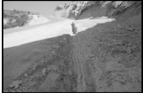
Imagen 35. Preparación de la sección para la incorporación de cunetas en los caminos que se ubican en el sitio de proyecto.
