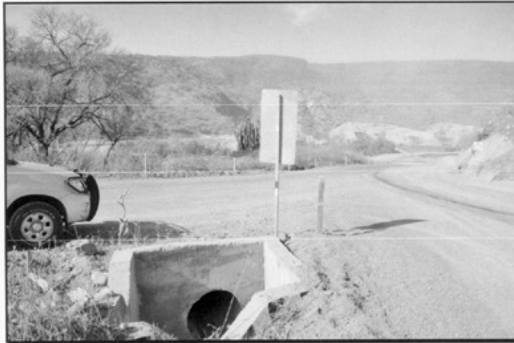
Imagen 37. Obra de infraestructura hidráulica para el manejo, control y alejamiento de las aguas pluviales en los caminos internos del proyecto
